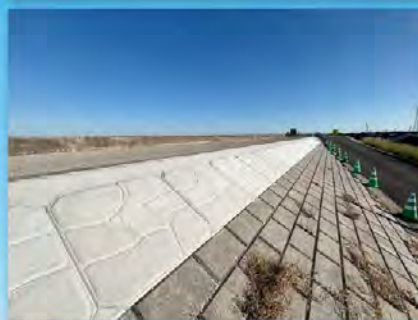
堤防の嵩上げ工事に採用されたCN-PCa
