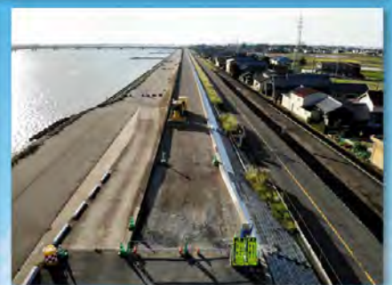
堤防の嵩上げ工事に採用されたCN-PCa
