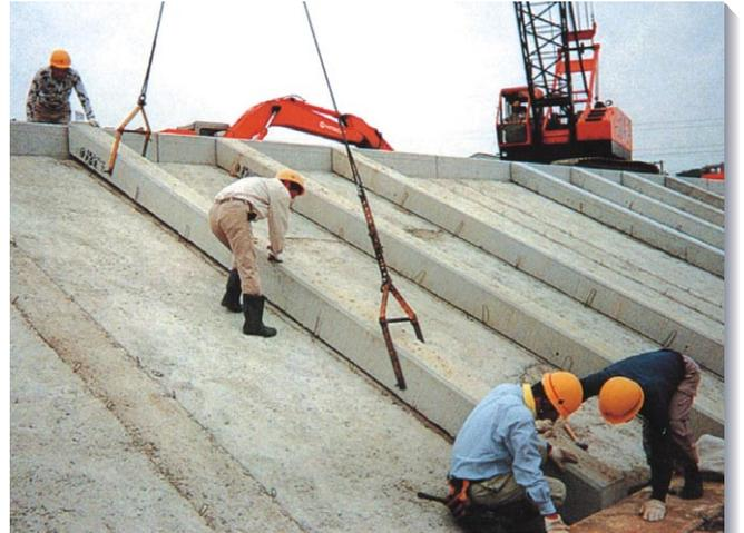
**2** あらかじめ均しコンクリートの表面に墨出して、据付ける位置を決めて仮据付けます。仮据付けした部材は「通り」「高さ」を見ながら、微調整し「くさび」を打って所定の位置に固定します。
