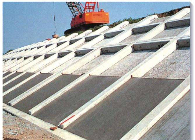
**4** 各部材を据付けたら、直ちに間詰めコンクリート打設ができます。
