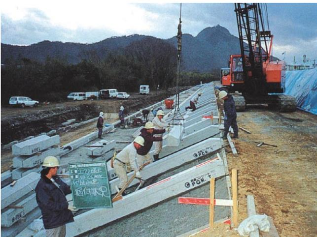
**3** 縦枠の据付けと併せて横枠・すべり止め据付けを行えば、より一層施工能率が上がります。
