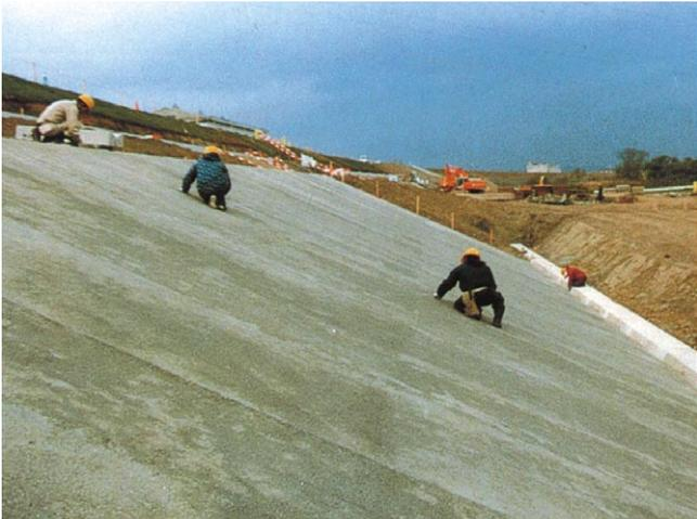
**1** 縦枠を据付ける部分の均しコンクリートは、凹凸のないように仕上げます。
